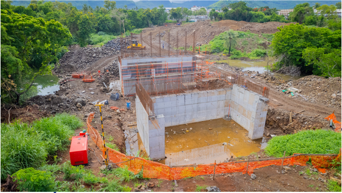
Construction of Bridge at Baie du Tombeau (in lieu of Pont Bruniquel) - RDA
